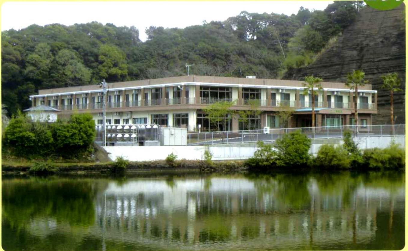
宮崎市浮田地区への移転改築工事が竣工した養護老人ホーム長寿園(平成25年3月)
